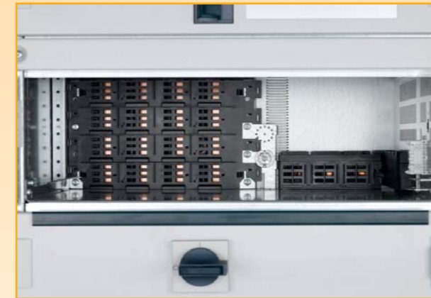
System szyn wtykowych w tylnej części przedziału
