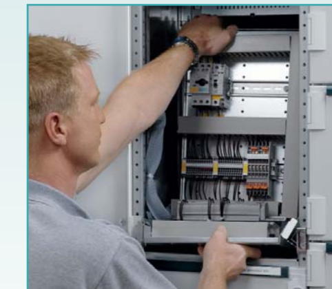
Wymowana płyta montażowa
